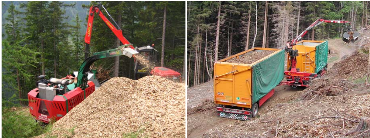
Abbildung 5: Wood Terminator 10 von MUS MAX hackt auf Böschung – Schüttgut-Lkw mit Kran und Schallengreifer lädt das Hackmaterial von der Böschung
