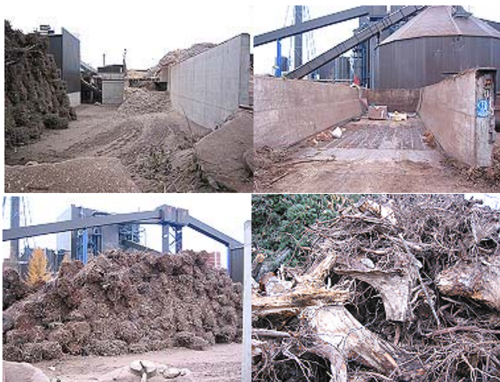
Abbildung 19: Die Übernahmestation und Brennstofflager des Kraftwerkes Jyväskylä bei Mikkeli. (Bild: Puhakka, A., Bioenergy Team Finland Oy)
