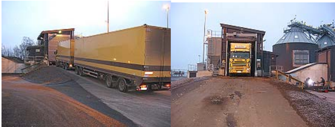
Abbildung 20: Moderne Übernahmestation des Kraftwerkes Kotka. In der Übernahmestation ist eine Absaubvorrichtung eingebaut, um Staubbelastungen der Umgebung während der LKW-Entladung zu vermeiden. (Bild: Puhakka, A., Bioenergy Team Finland Oy)
